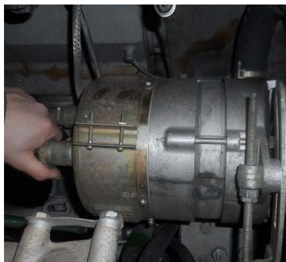
Рисунок 2.27 – Проверка крепление силового провода «+» к генератору
