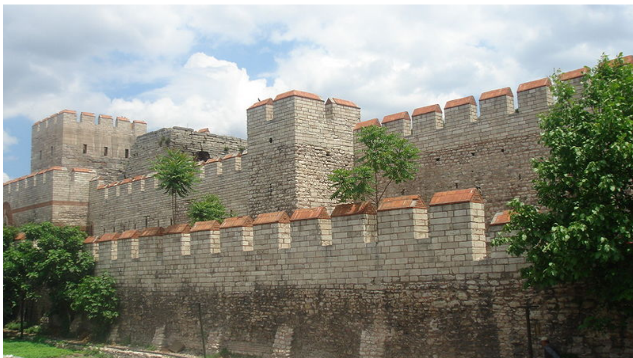
Рисунок 1.13 – Реконструированный участок Феодосиевых стен
